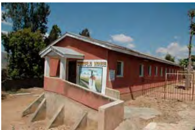
Edificio per donne gravide in attesa di parto
