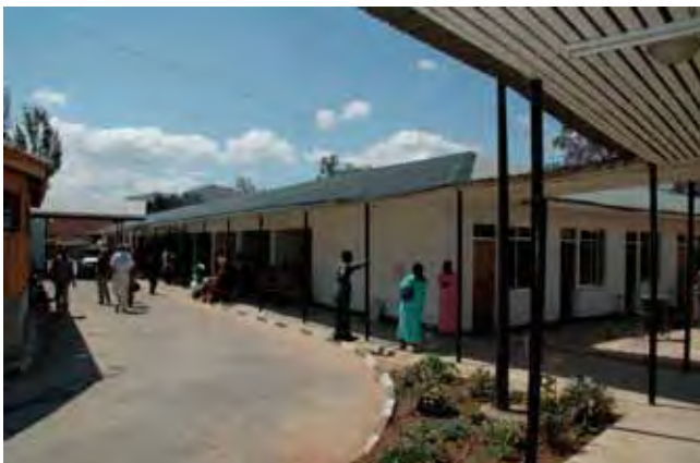
Particolare degli ambulatori per pazienti esterni
