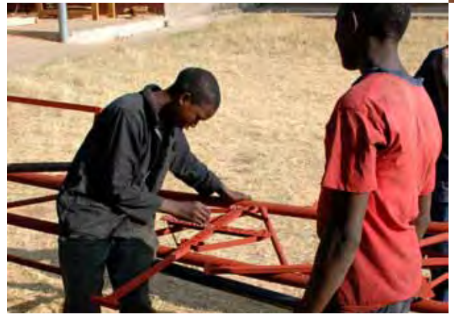
Attività di carpenteria
